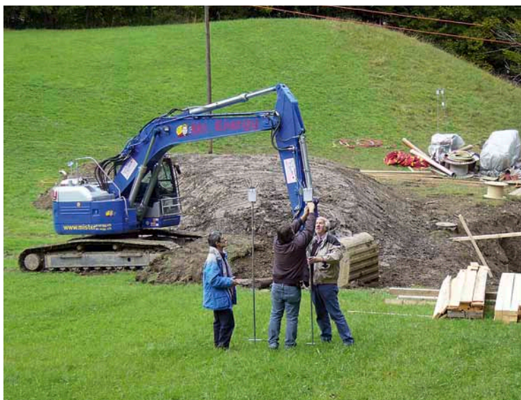
Spécialiste du sol inspectant un chantier
